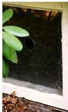
Foto: ERIK LÖTBERG/IHF Källarfönster på en villa i Norby i Uppsala. Fönstret tros ha skadats under ett åskväder den 6 augusti 1994. Skadan upptäcktes först ett par dagar senare. På bilden nedan syns hålet i närbild.
